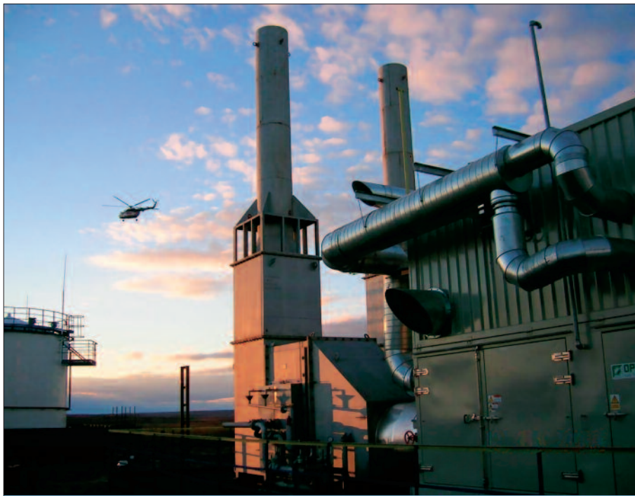
Рис. 2. Две ГТУ OP16 эксплуатируемые на Тэдинском месторождении
