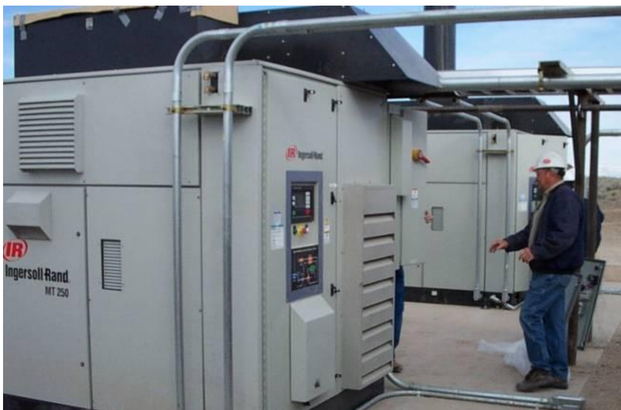
Микротурбина MT250 электрической мощностью 250 кВт
